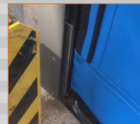
Rail de guidage avec système de fermeture à glissière et plinthe basse FlexEdge
