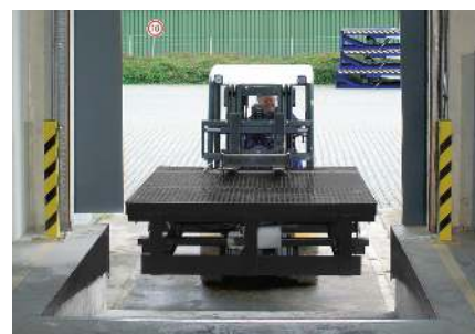
Neue Ladebrücke einsetzen
