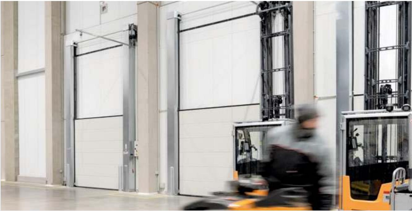
**Die anpassungsfähigen H-Beschläge (höhergeführt) und V-Beschläge (vertikal)**
