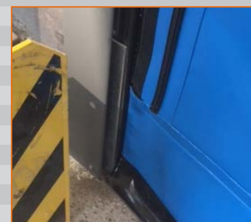
Führungsschiene mit Zip-System und Flex-Edge-Schließkante
